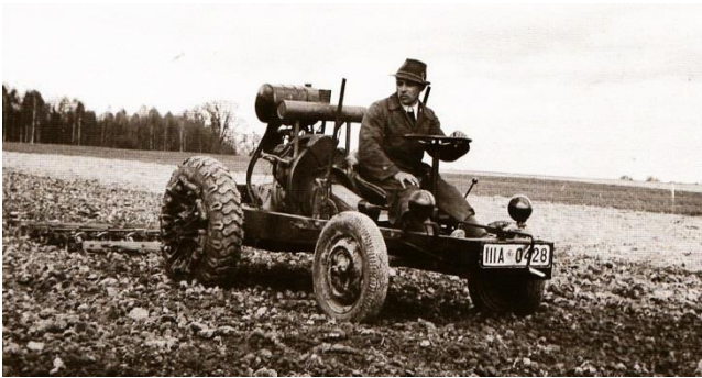
Prototype 110 S-1 met een 2-cilinder Otto motor.
